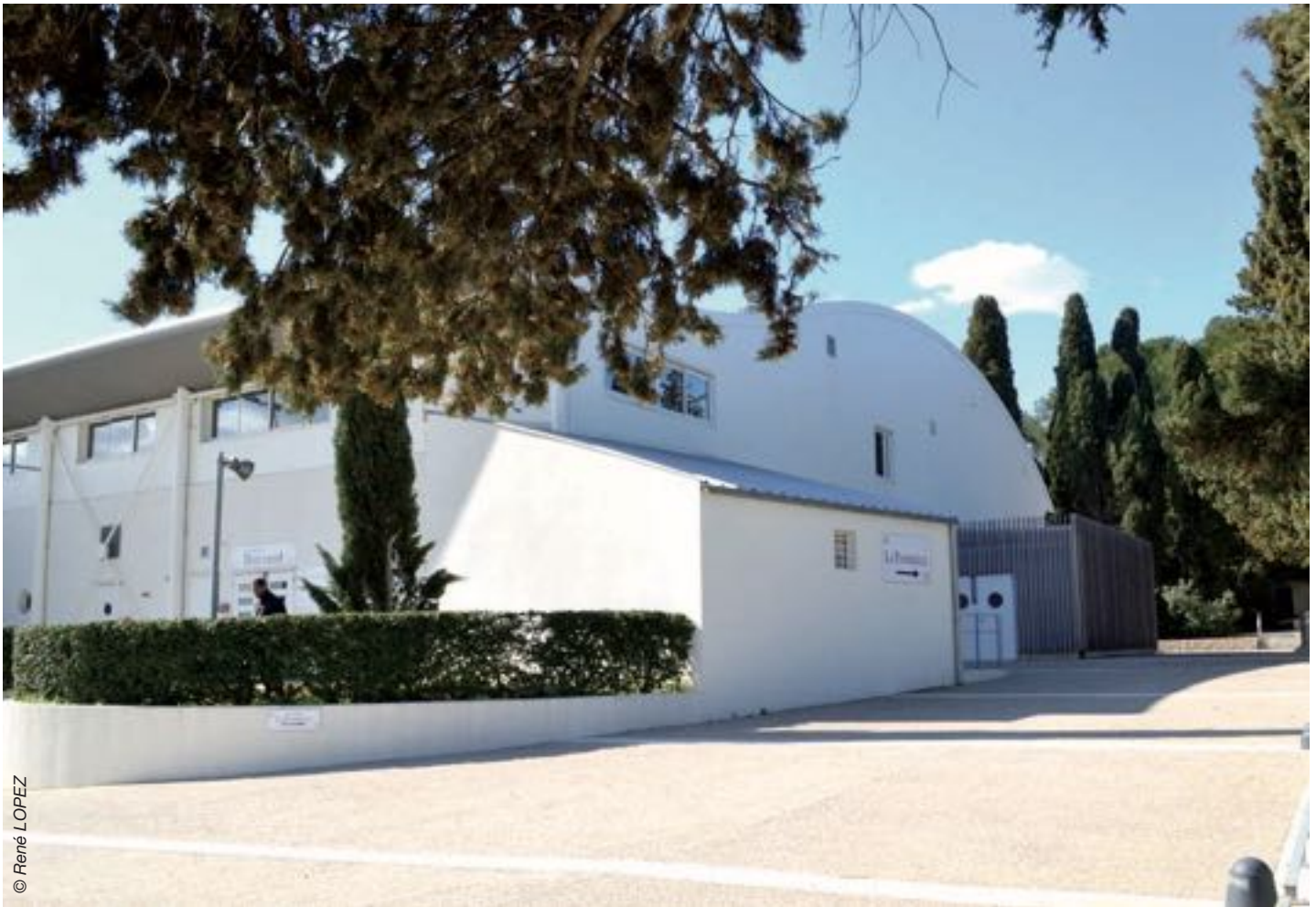
Ph. 20 La Passerelle, salle de spectacle
